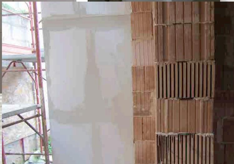
I ponti termici presenti in corrispondenza dei pilastri e dei solai sono corretti grazie alla posa di pannelli in polistirene tipo **POLISULPOL SL** dello spessore di 30 mm direttamente a contatto con l'elemento in cemento armato e successivo rivestimento con tavelle in laterizio del medesimo spessore.
